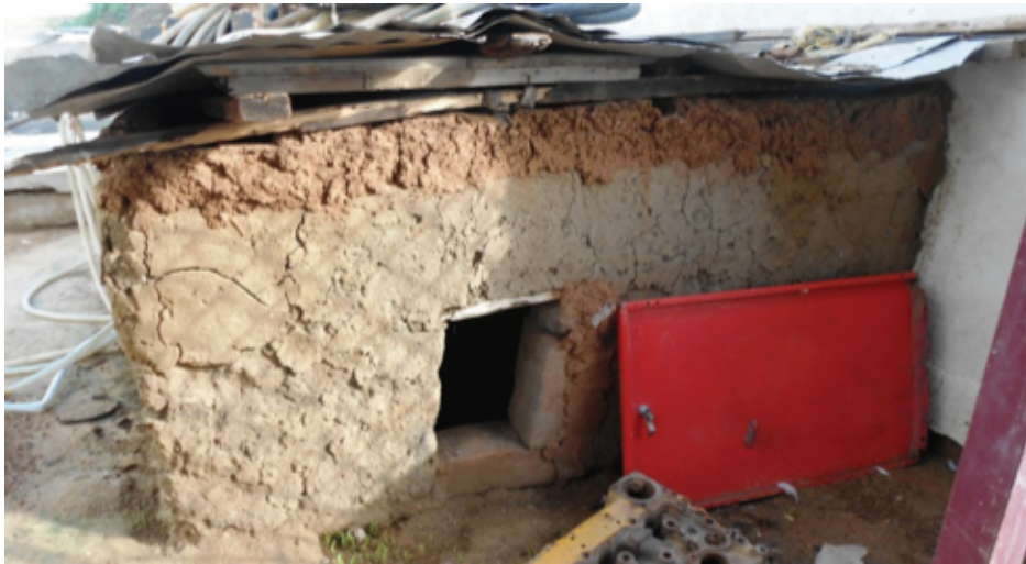
Figure 3. Exemple de logement de pintade
