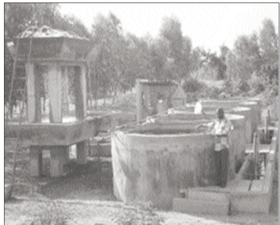
Photo 2. Bassins en ciment en recirculating system, conçus par l'inventeur avec l'appui de Mr Oscar Compaoré, Ingénieur en béton en 2007 et installé au palaisq de la présidence à Ouagadougou.
