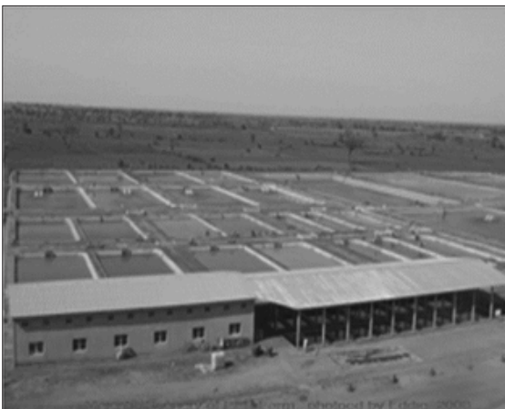
Photo 1. Etangs et bassins installés à Bagré de 2006 à 2010 par la Coopération taiwanaise sous le suivi technique de l'inventeur.
