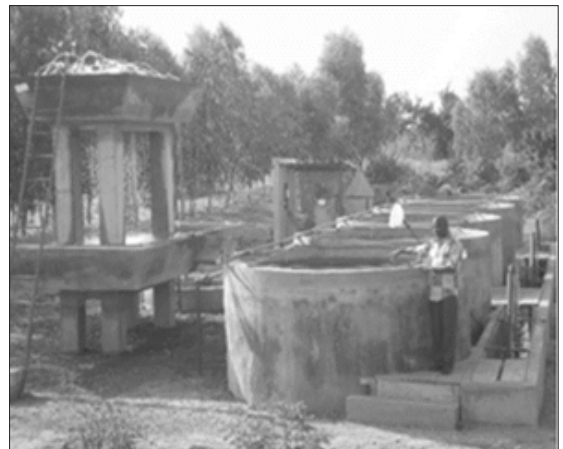
Photo 2. Bassins en ciment en recirculating system, conçus par l'inventeur avec l'appui de Mr Oscar Compaoré, Ingénieur en béton en 2007 et installé au palaisq de la présidence à Ouagadougou.
