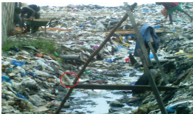
Photo 2 : Tuyau d'évacuation des eaux usées relié à un drain
