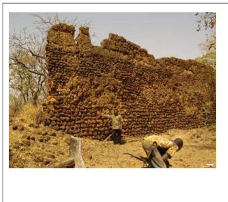
Photo 4. Pan de la muraille d'enceinte avec la bauge faîtière.
