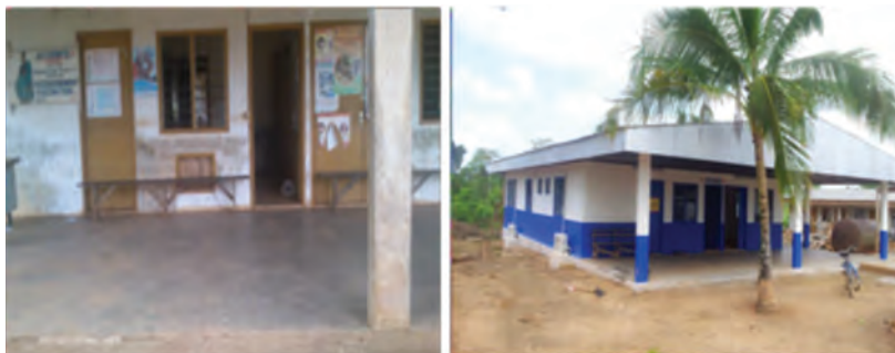
Photo 6 : Réhabilitation de la maternité de Wonséaly (Soubré). Cliché du CCC, 2014.
