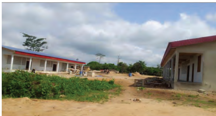
Photo 7 : Projet V4C: Construction d'une école primaire de 6 classes avec bureau de maître, cantine et latrine à Petit Béoumi dans le département de Soubré. Cliché du CCC, 2014.
