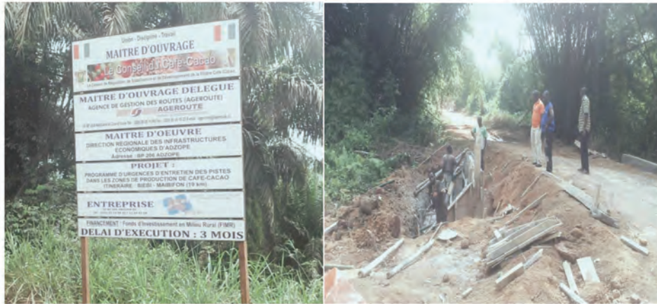
Photo 3 : Fourniture et pose de buse sur l'axe Ahouabo-Scaf, Pk 9.3 (Département d'Adzopé). Cliché du CCC, 2014.
