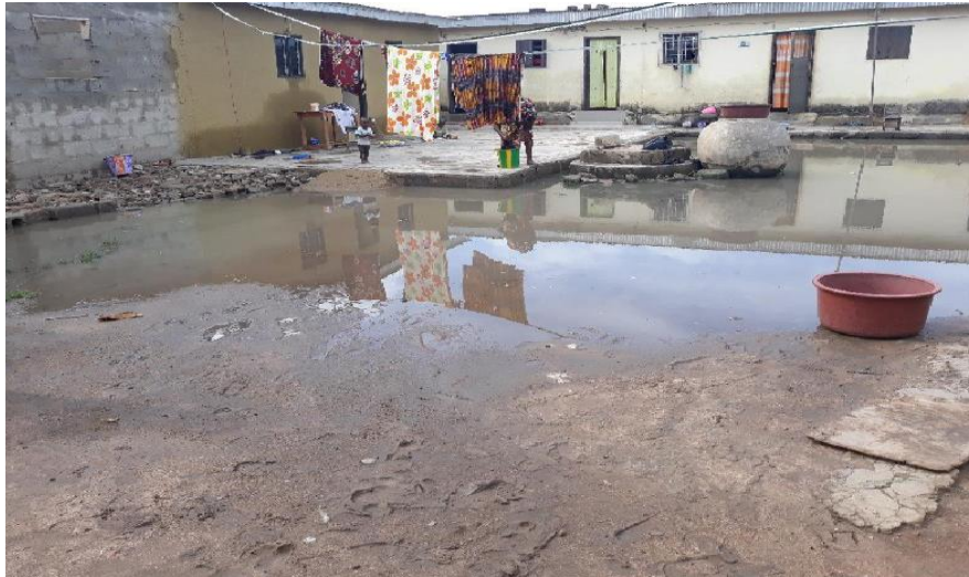
Photo 1 : Stagnation d'eau pluviale au quartier savonnerie, Clichés : auteurs, juillet, 2018
